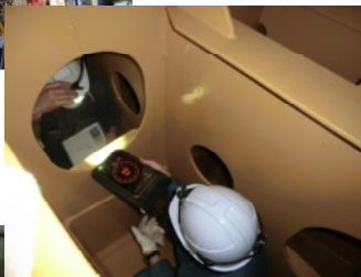
Aft Peak Tank 内 (機関室後ろ)
