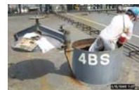
図1 タンク入口 (ハッチ)
